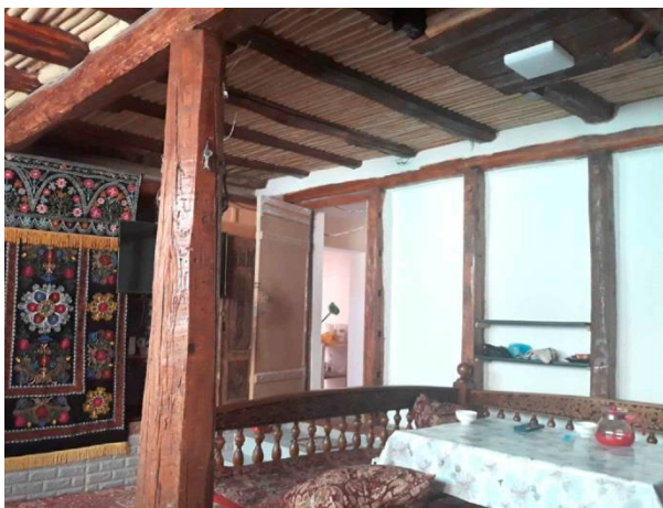
Интерьер дома существующего в настоящее время, с двойной каркасной ( кўштинч девор ) конструкцией. Автор фото: J. S. Abdullayev
